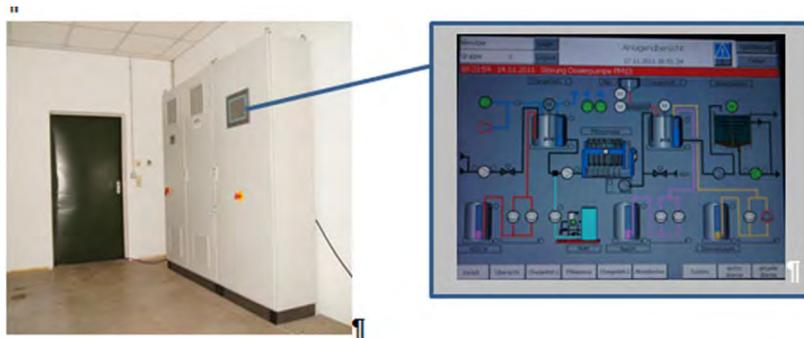
Abbildung 2.8: Steuerschrank mit touch panel
