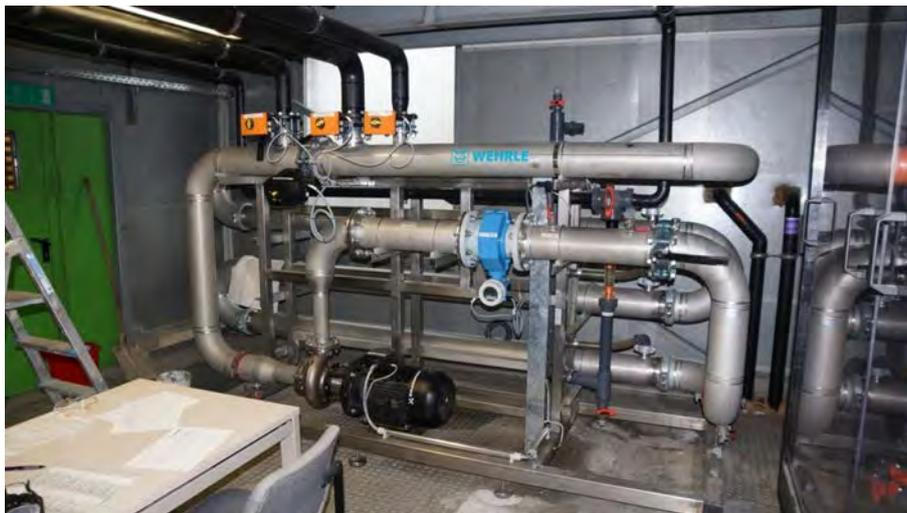
Abbildung 2.18: Ultrafiltrationsanlage auf der Pilotanlage Offenburg
