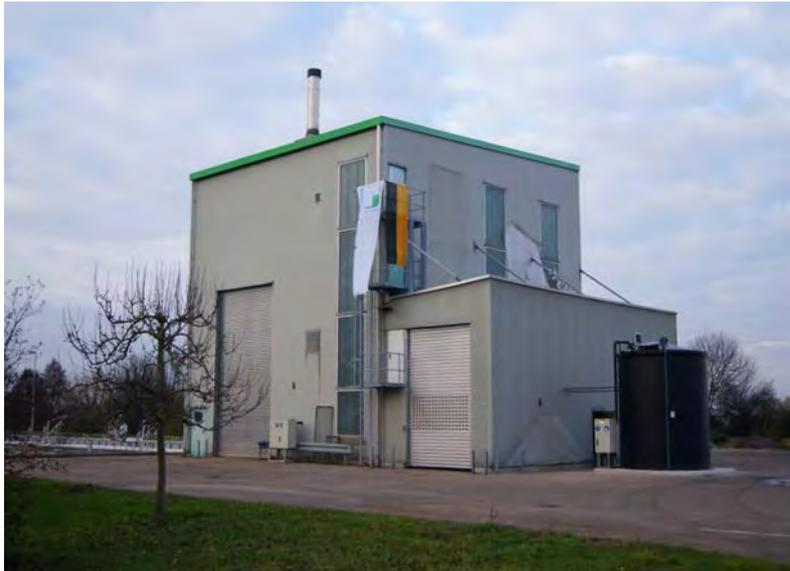
Abbildung 2.4: Ehemaliges Trocknungsgebäude zur Unterbringung der MAP-Pilotanlage mit Anbau für die Kammerfilterpresse und außenstehendem Lagertank für Schwefelsäure
