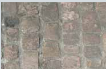
Steinbelag mit Fugenverguss
